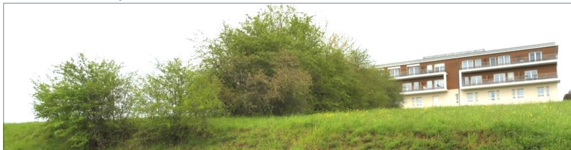
Haie existante en traversée de l'angle Nord-Est de l'îlot c1.
