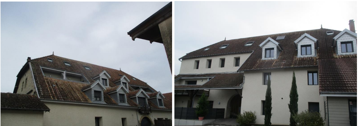
Rénovation d'une ancienne ferme en logements collectifs Chalezeule, Grande rue – 2025
