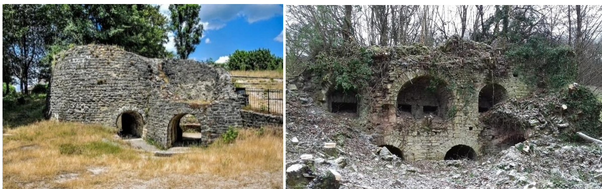
Four à chaux à Chalezeule (@J.E) et Gypserie à Vorges-les-Pins (@Bernard Cretin)
