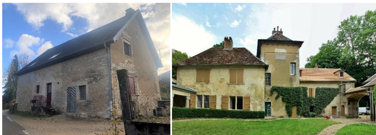
Maison de maître/ferme à Besançon (quartier Tilleroyes) (@GRAHAL Conseil) et Grange Huguenet à Besançon (quartier Montrapon-Montboucons) (@JGS25)
