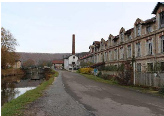
Ancienne papèterie de Deluz, à cheval entre le canal et un barrage
