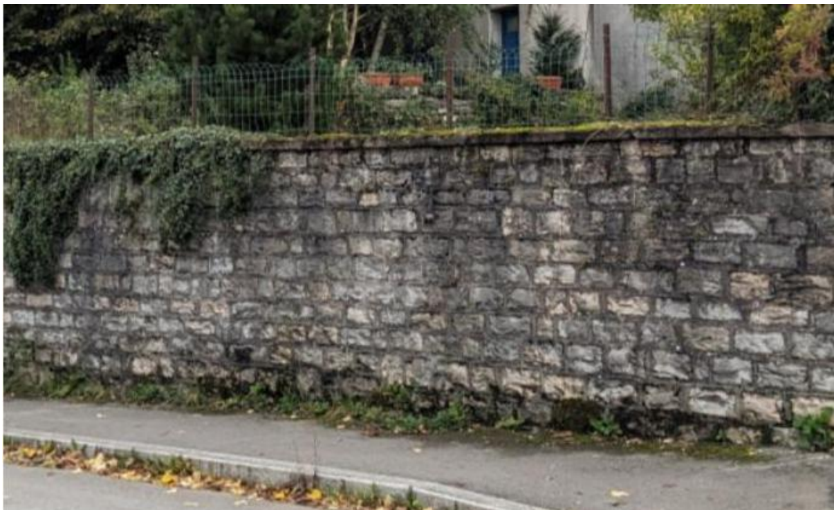
Murs traditionnels en pierres maçonnées (@Citadia)
