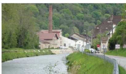
La cheminée de la papeterie de Deluz marque la présence du bourg depuis l'entrée nord (RD266).
