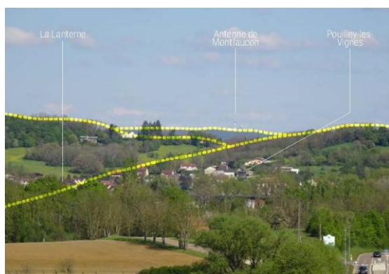
Depuis la RD70, à hauteur de Champagny, l'antenne de Montfaucon souligne la présence du relief qui constitue l'arrière-plan des horizons.
