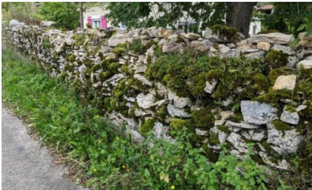
Murs ou murets de pierres sèches (@Citadia)
