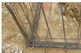
Nœud de chaînage - Continuité mécanique
