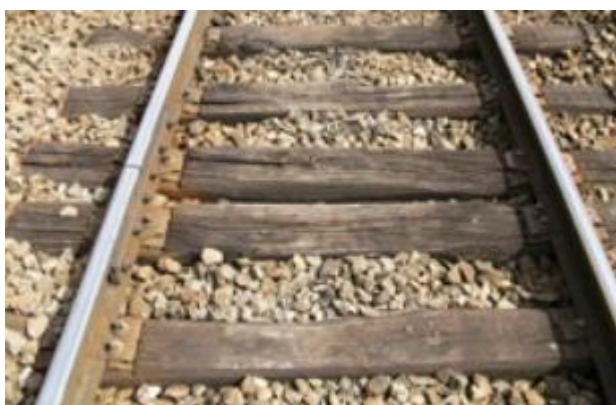
Rails courts sur traverses bois
