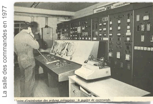
l'usine d'incinération des ordures ménagères : le pupitre de commande.
